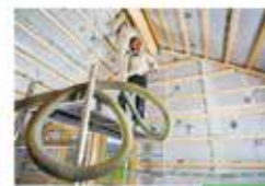
Einblasdämmung
