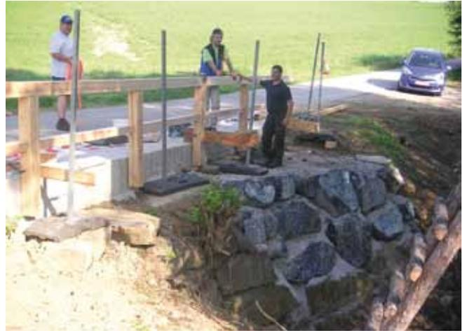
Bei der Grubhofbrücke musste der Unterbau ausgebessert und ein neues Gelände angebracht werden.
