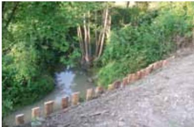
und diese samt dem Weg in den Sichelbach zu rutschen drohte. Mittels „Piloten“, das sind Holzpflocke, die vom Perschling-Wasserverband eingeschlagen wurden, konnte die Abrutschgefahr der Böschung und des Weges beseitigt werden.
